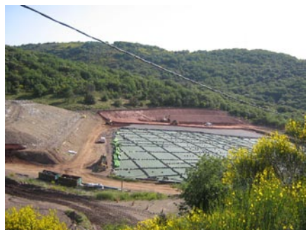
Vue générale de l'ISDND
