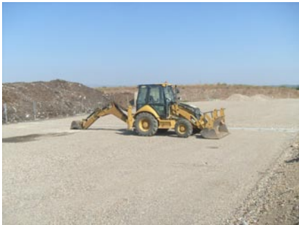
Extension de la plateforme de compostage
