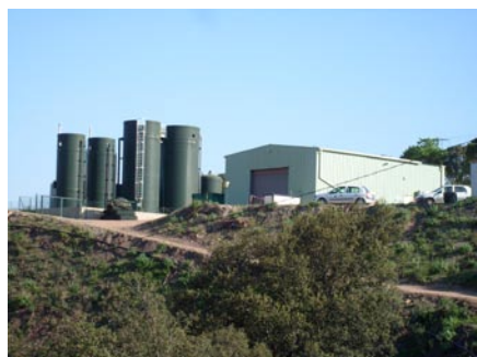
La station de traitement des lixiviats
