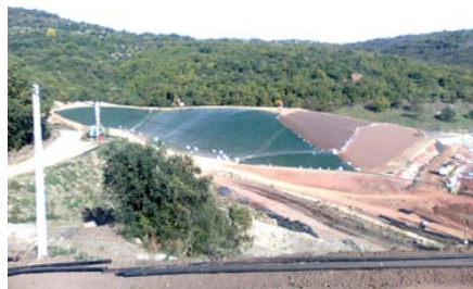
ISDND : ancien casier en cours de réhabilitation
