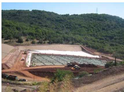
ISDND : aménagement du nouveau casier
